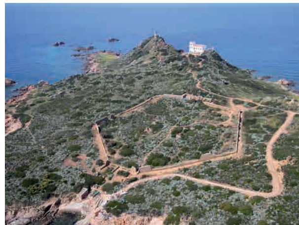
Le Lazaret de Mezu Mare, travaux de réhabilitation et d'aménagements.
