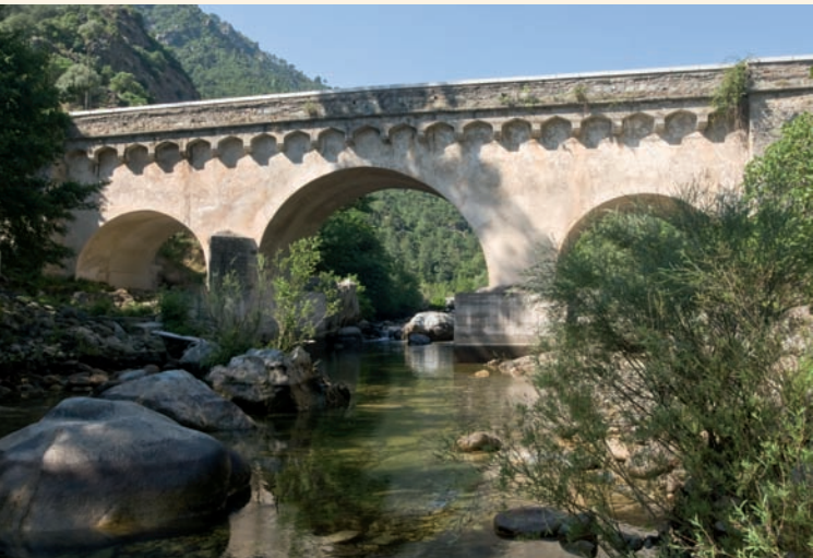
Ponte di Castirla.
