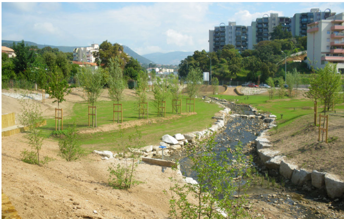
Document 5a : le bassin de rétention de la Madunnuccia.
