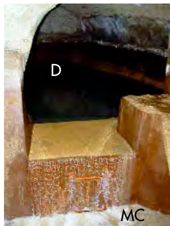
Vue de la chambre de décantation (D) et de mise en charge (MC).
