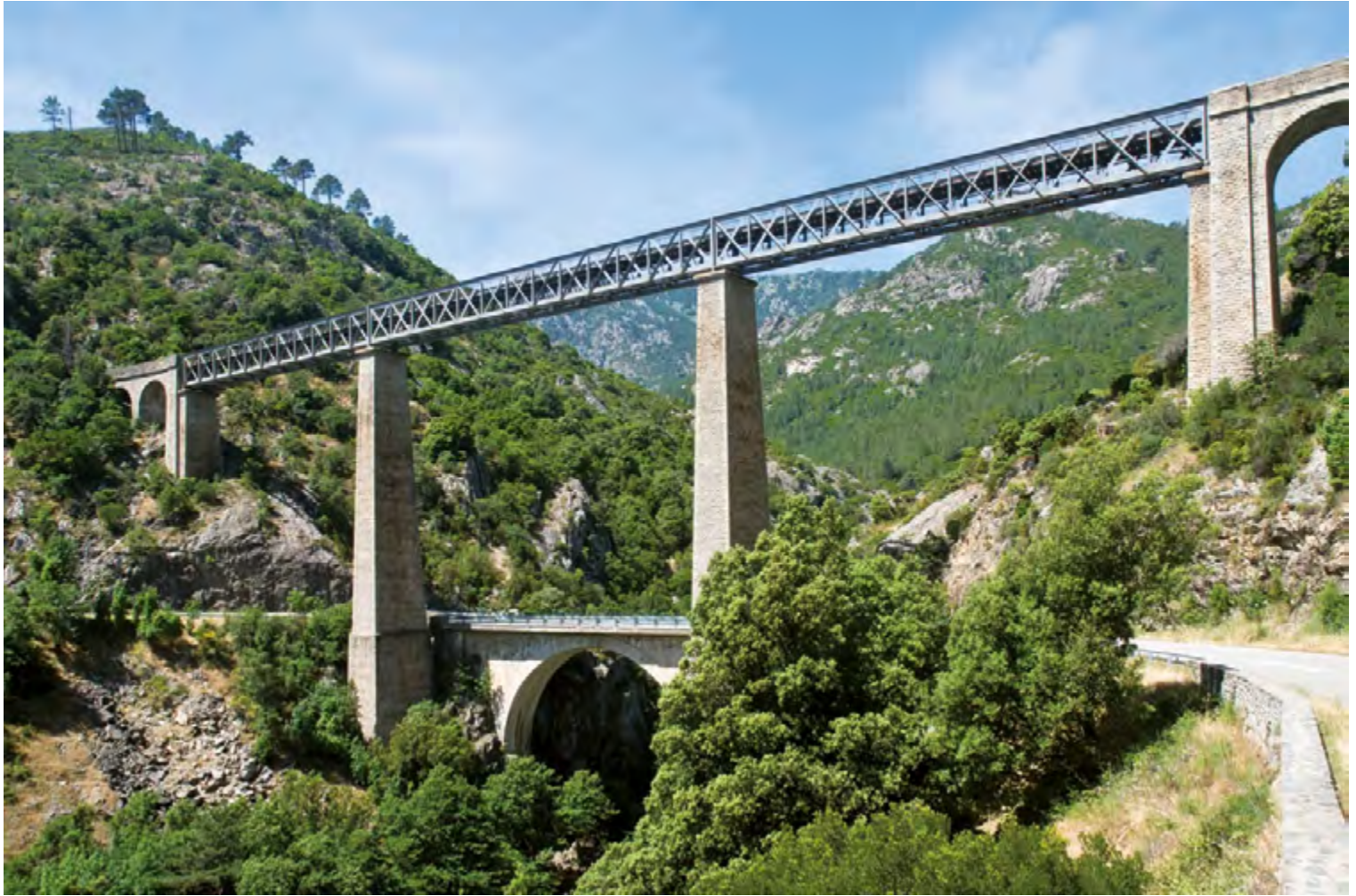
Viadottu nantu à u Vechju o Ponte Eiffel, 1891-1893
