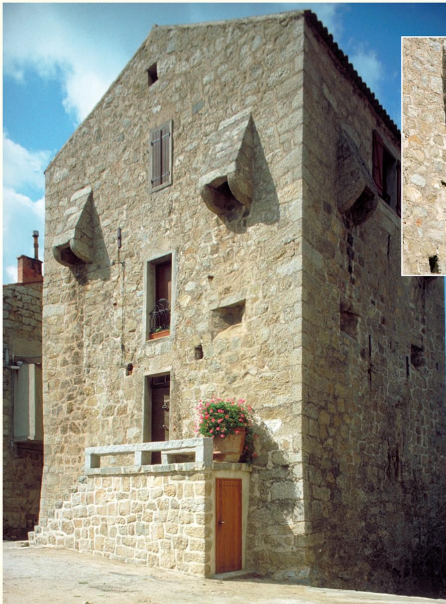
fenêtre. En revanche, l'archère de la façade donnant sur la place n'a pas été murée de l'extérieur et montre une chambre de tir largement échantonnée vers le bas, permettant l'usage de l'arqebuse. En définitive, la fonction initiale de l'édifice reste donc très lisible en l'état actuel.
